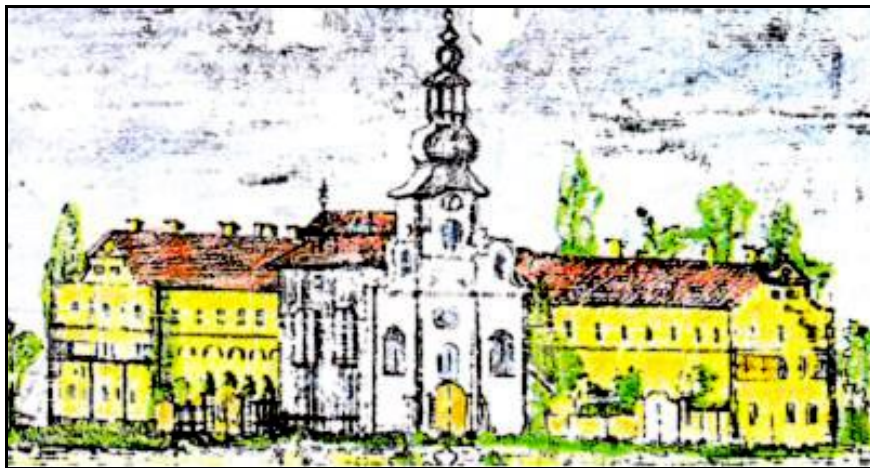
Vorläuferkirche mit gräflichem Haus(links) und ehemaligem Konvikt(rechts).
